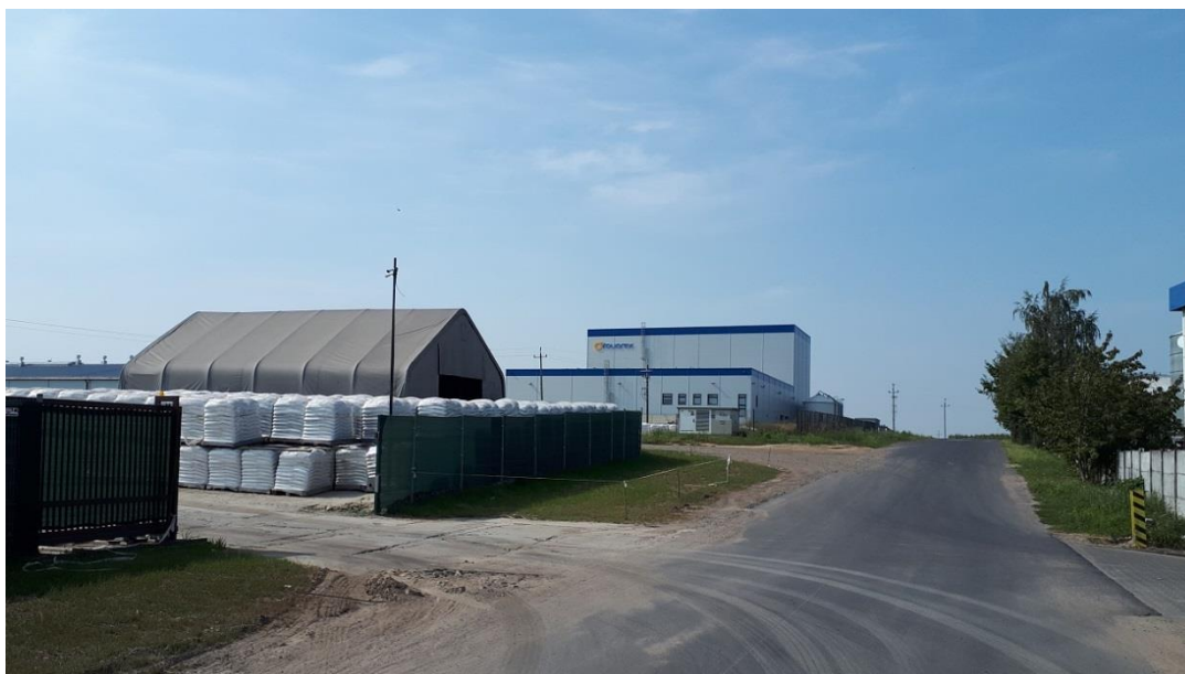
Fot. 1. Widok na ul. Zachodnią
